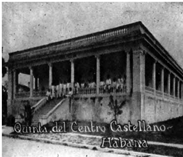
- Quinta de Salud "Santa Teresa de Jesús" del Centro Castellano de La Habana , La Habana, h. 1925. En: Album Cuba en 1925 . Cigarros Susini / Henry Clay and Bock and Co. Ltd. La Habana, 1925.
