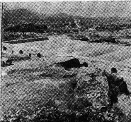
DEPOSITO DISTRIBUIDOR. —Este depósito en cola de la distribución con sus 500 metros cúbicos de capacidad asegura una dotación suficiente para las necesidades de Ferosalle. En esta página puede verse ya terminado y en varias fases de su construcción. Las dos fotos inferiores corresponden al detalle de una bóveda y al abovedado que cubre el depósito.
