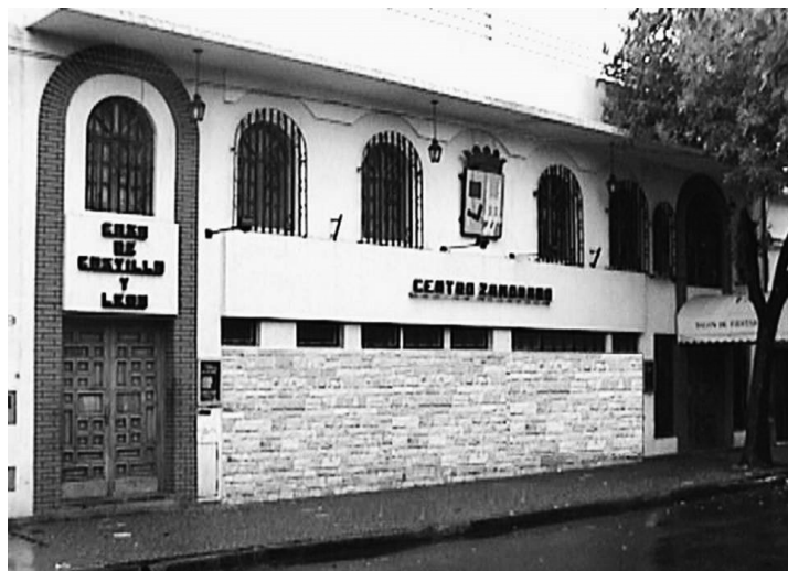
Fachada del Centro Zamorano de Buenos Aires realizada en 1990.
