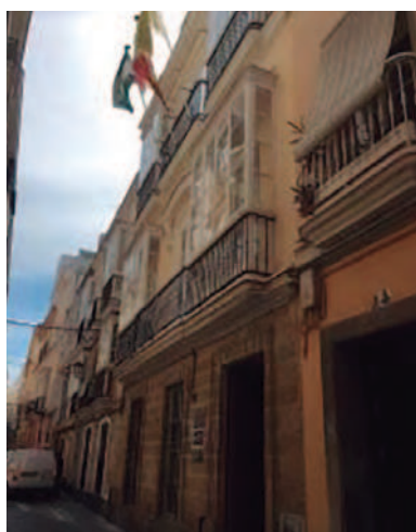
Fachada de la casa.
