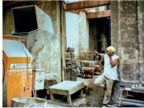
El local cuando comenzó la reparación.
